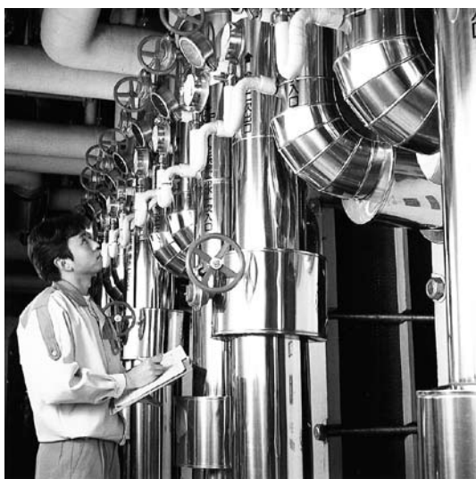
設備管理作業のようす
